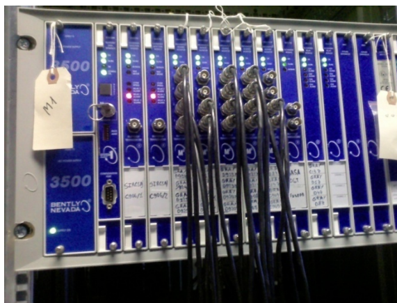
Рис. 1. Подключение к нормированным выходам системы 3500 BentlyNevada
